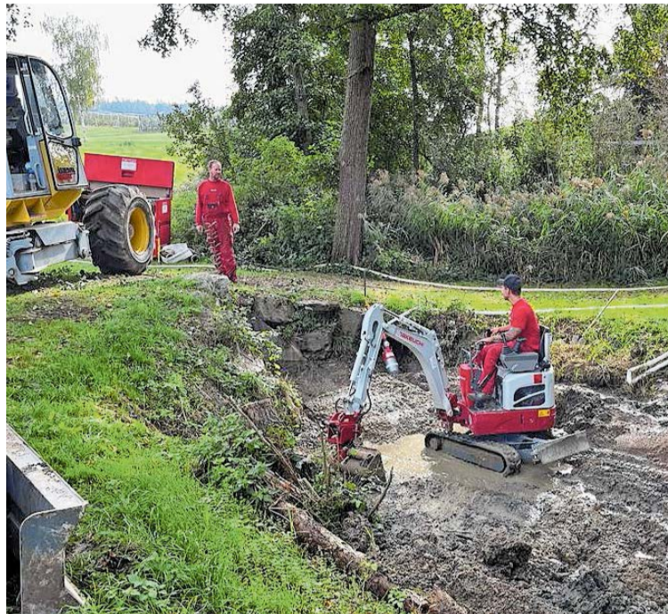
Beim Uhwieser Weiher wurden insgesamt rund 80 Kubik Schlamm und Erde ausgehoben (Bild links). Auch die Röhre, die als Zugang zum Bach dient, wurde freigelegt. Vor den Arbeiten wurden Krebse und Fische vom Vorschlammer in den Weiher transportiert (Bilder rechts). Bilder: jbe/zvg
