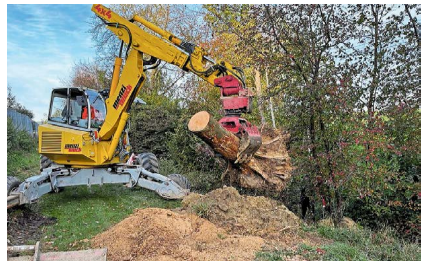
Die Erde wurde weiter unten genutzt, um die Bachböschung aufzuwerten. Auch ein zwei Tonnen schwerer Wurzelstock wurde eingebettet.
