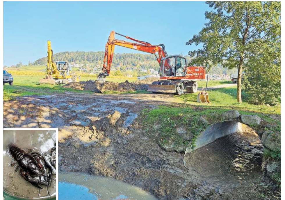
Beim Uhwieser Weiher wurden insgesamt rund 80 Kubik Schlamm und Erde ausgehoben (Bild links). Auch die Röhre, die als Zugang zum Bach dient, wurde freigelegt. Vor den Arbeiten wurden Krebse und Fische vom Vorschlammer in den Weiher transportiert (Bilder rechts). Bilder: jbe/zvg
